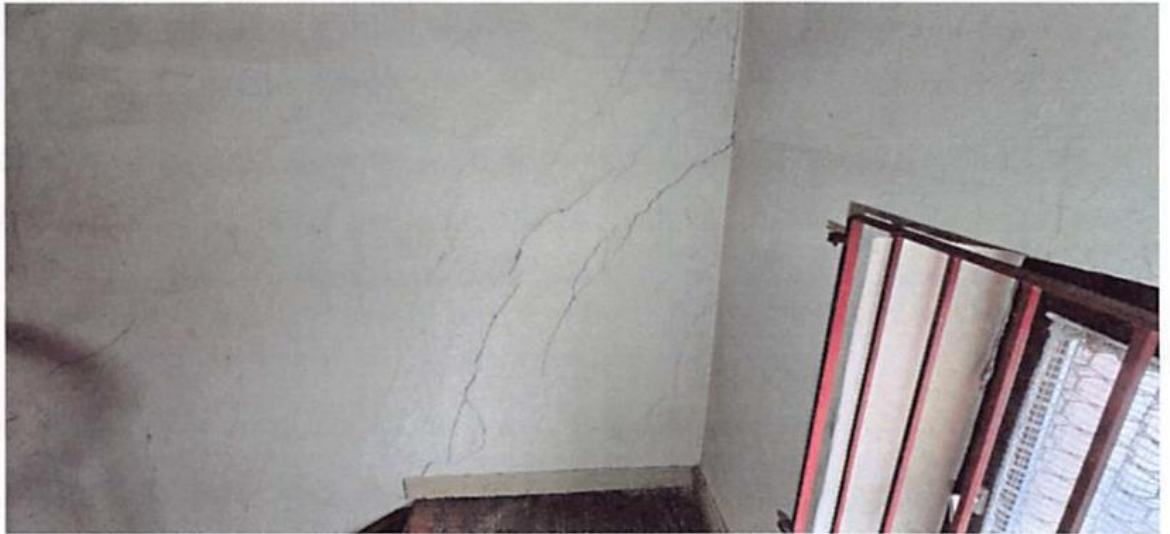
Treppenhauswand Ost, OG/DG
