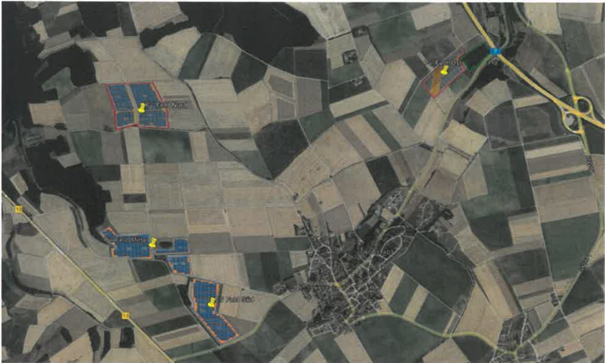
Bild 2.1.2: Detailansicht der PV Flächen (Quelle: Google Earth/SolPEG)
